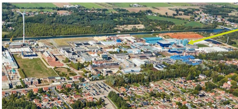
Voorziene locatie voor plaatsing van de nieuwe windturbine op de Umicore site in Olen
